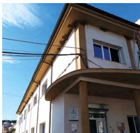
▲ Cornisa antes de la instalación.
