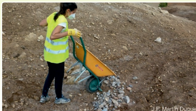
Figura 3. Izquierda, proceso de extendido de carga de fondo en los nuevos cauces fluviales. derecha, aspecto final del armado de uno de los nuevos cauces fluviales.
