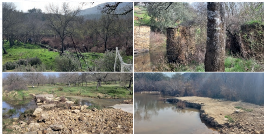
▲ Adecuación cerramientos perimetrales de fincas, perpendiculares al dominio público hidráulico.
