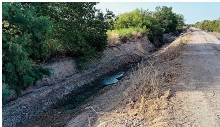
⚡ Filtro verde y camino de operaciones antes de la actuación (Foto: Pablo Navarro).
