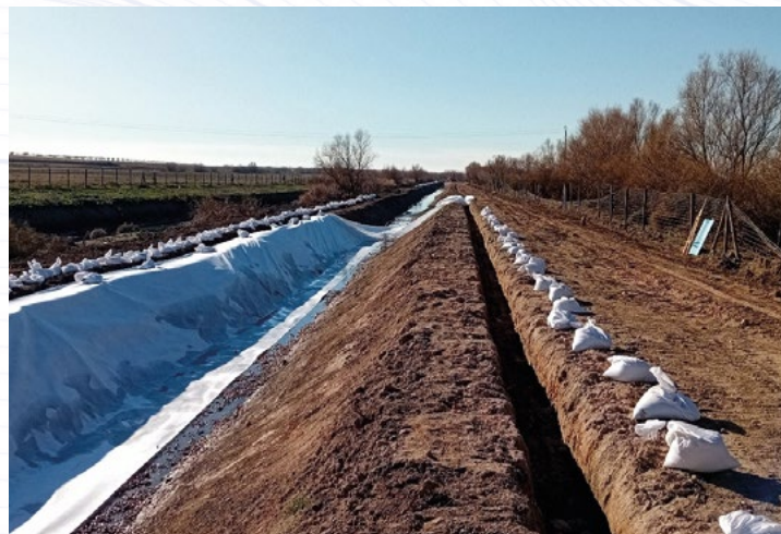
⚡ Vaso del canal durante la instalación de láminas de geotextil y anillos de amarre (Foto: Pablo Navarro).
