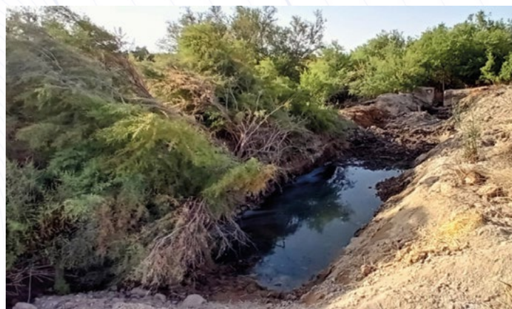
⚡ Desemboque del filtro verde con el canal de pluviales antes de la actuación (Foto: Pablo Navarro).
