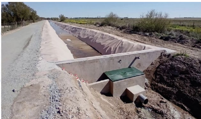
✓ Dique con compuerta reguladora del canal al final del filtro y camino de operaciones readecuado (Foto: Pablo Navarro).
