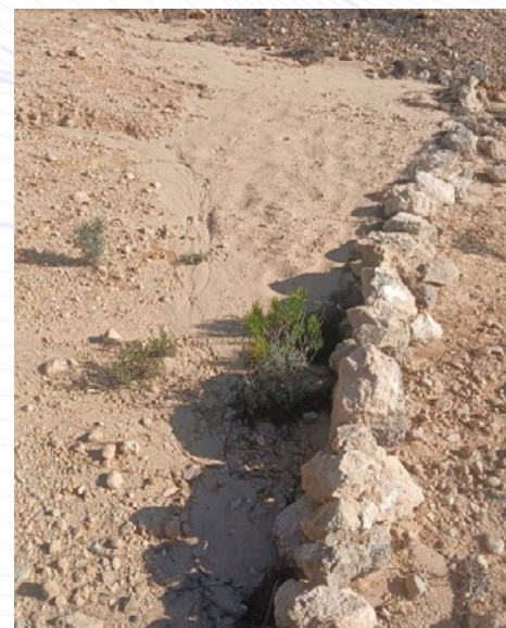
⬆ Barreras de piedra para retención de arenas.
