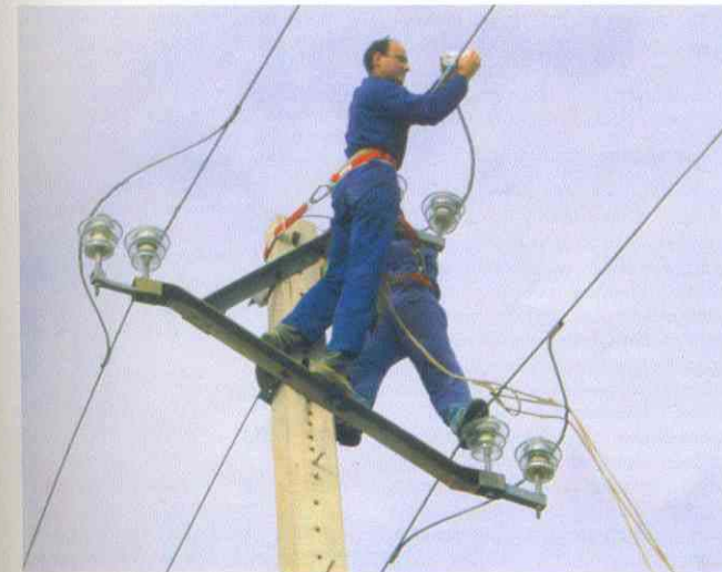
Aislamiento de los apoyos en tendidos eléctricos.
