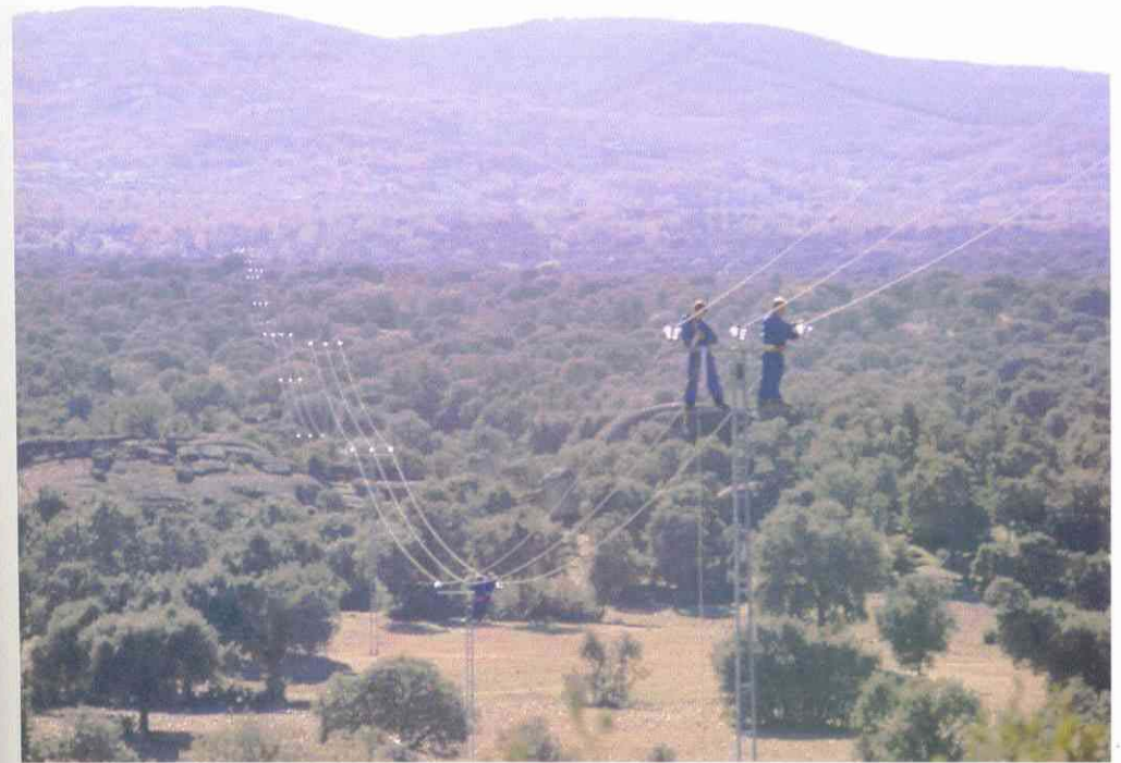
Aislamiento de los apoyos en tendidos eléctricos.
